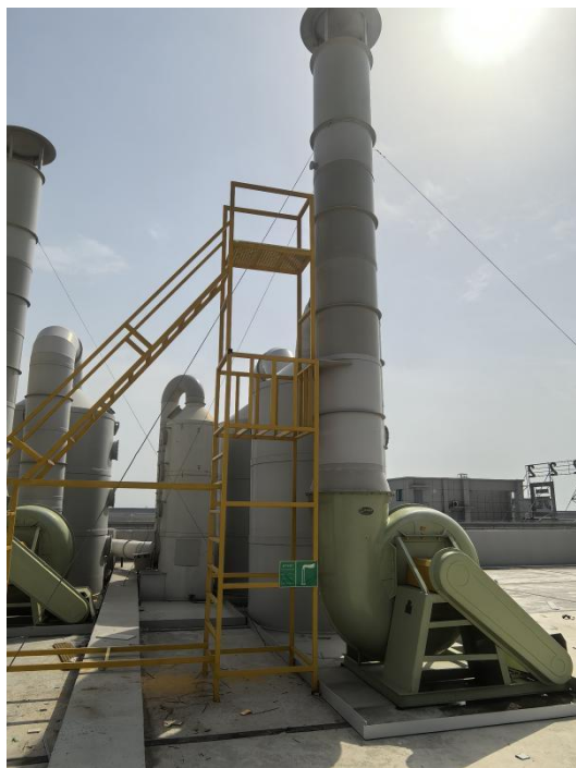
酸雾废气处理装置（碱液喷淋吸收） 含氰废气处理装置（碱液喷淋+次酸氧化）
