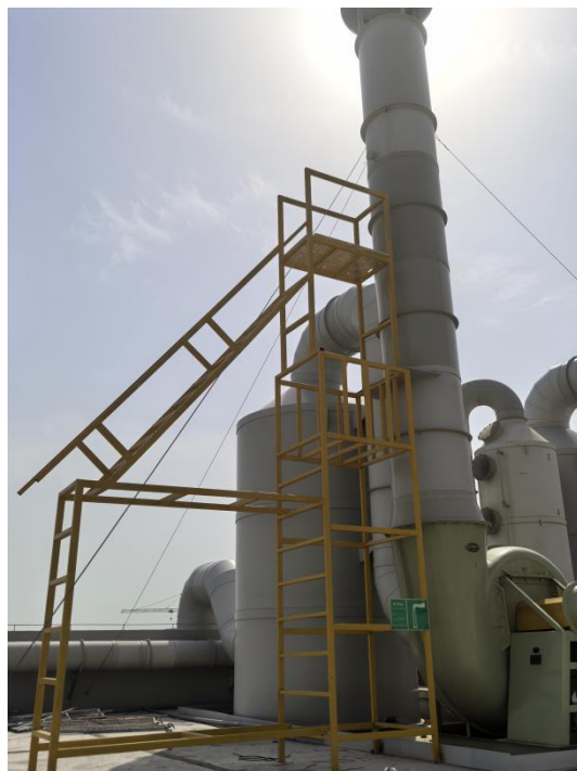
酸雾废气处理装置（碱液喷淋吸收） 含氰废气处理装置（碱液喷淋+次酸氧化）
